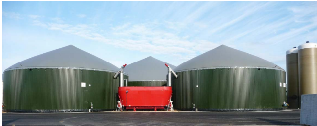
Co-vergistinginstallatie, Cremershoeve, Tynaarlo 1,1 Mwe Beschikbaarheid 98,9%
